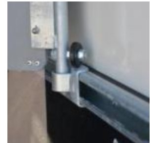
Mechanisches Sperrsystem für eine leichtere Benützung der Trennwände.
